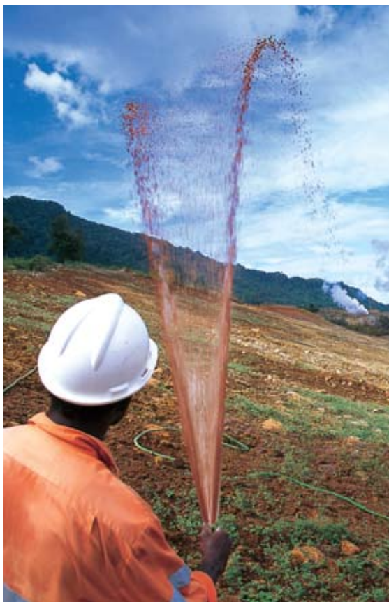
L'« ensemencement hydraulique » destiné à restaurer la végétation consiste à pulvériser un mélange de graines, d'eau, d'engrais et de paillis sur une terre végétale récemment épanchée. En l'espace d'un mois, la végétation aura commencé à croître.
