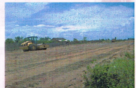
Fig. 18 Travaux de terrassement voie d'accès
